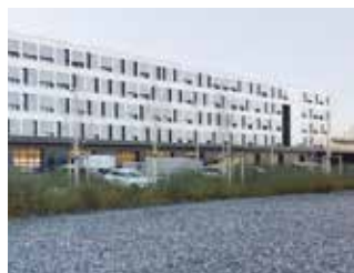
Gewerbehof Laim Munich, Germany
